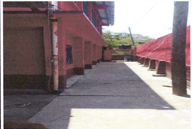
Foto 4: Presentación del muro de contención de la escuela
